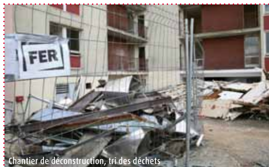
Chantier de déconstruction, tri des déchets
